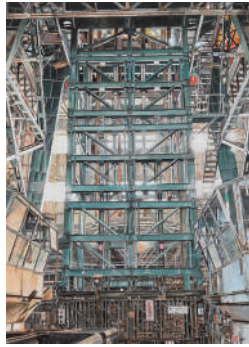
新人賞 立坑槽 館小路裕範
